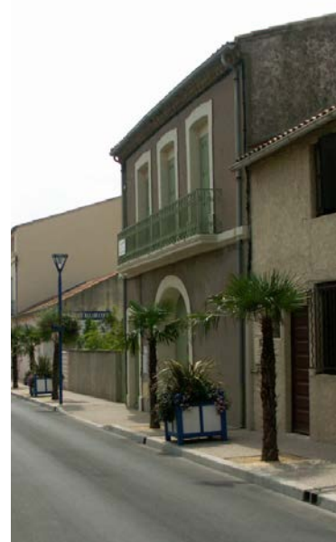
Façade sur rue enduite et pignon en pierres rejointoyées
