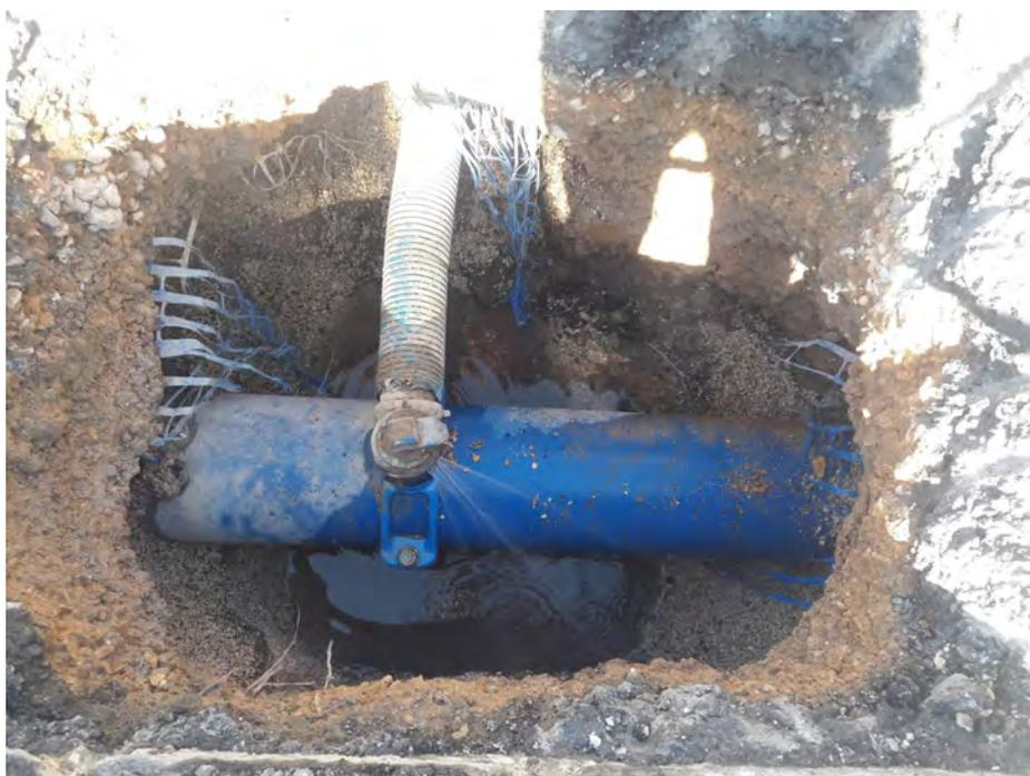
*Figure 7 : Fuite sur collier de prise en charge.*
