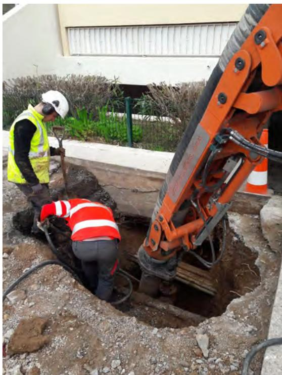
*Figure 6 : Terrassement à l'aspiratrice à Balaruc les Bains.*
