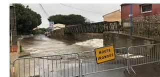
Sécurisation passage à gué
